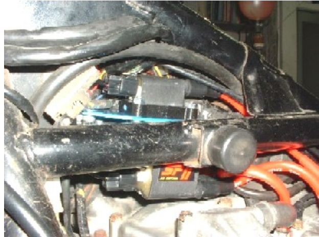
図4 SP2 コイルの取付
